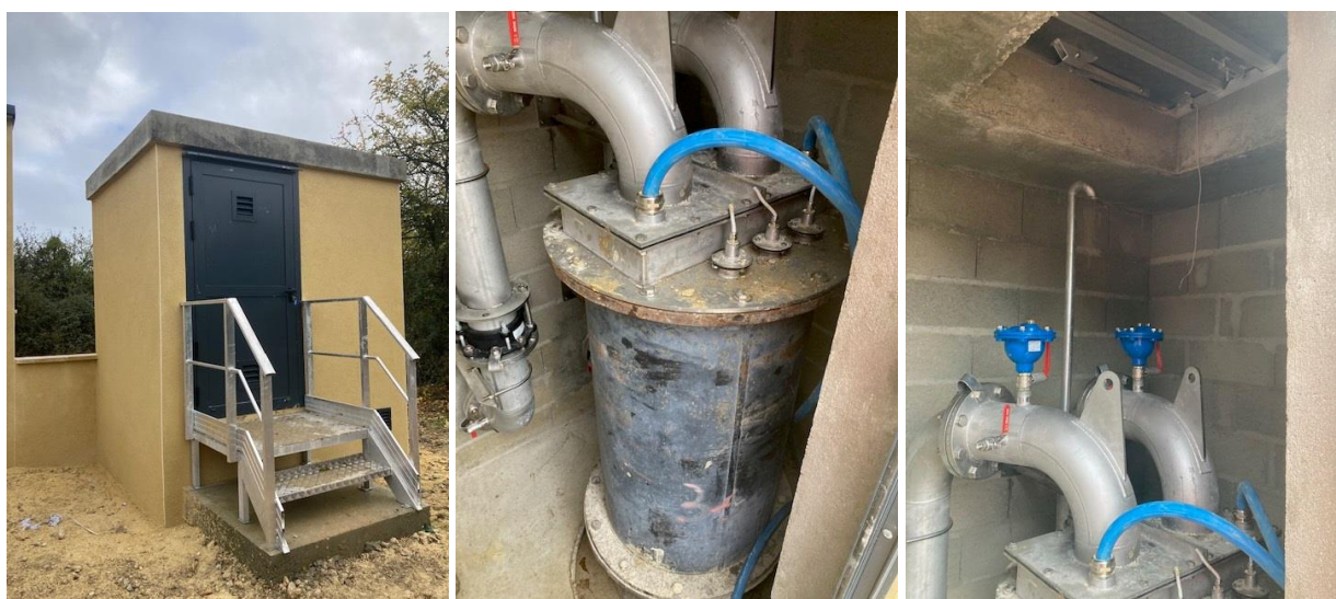
Local technique et tête du forage F2
